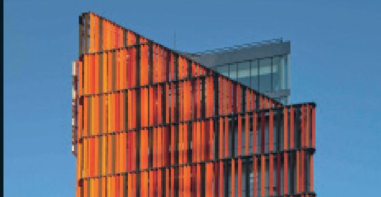
**Les panneaux composites en aluminium ALPOLIC™/fr sont composés de deux tôles d'aluminium de 0,5 mm d'épaisseur fixées sur un cœur polymère minéral difficilement inflammable à l'aide d'un procédé de fixation par fusion.**
