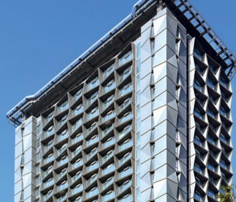
**Les panneaux composites en aluminium ALPOLIC™ A2 sont composés de deux tôles d'aluminium de 0,5 mm d'épaisseur, fixées sur un cœur minéral incombustible à l'aide d'un procédé de fixation par fusion. Ils peuvent être livrés dans des largeurs allant jusqu'à 2 m, ce qui est unique au monde.**
